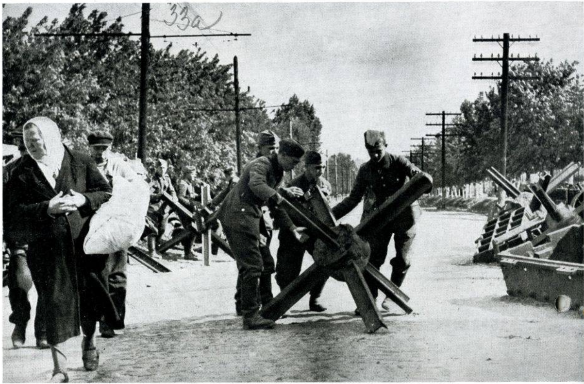
STRASSENSPERREN WERDEN SCHNELL BESEITIGT...
