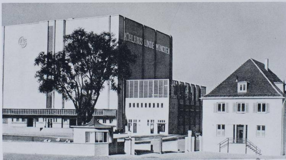
El moderno frigorífico Linde, de Munich, con un área útil de 11,500 metros cuadrados. A la izquierda el frigorífico, al centro la casa de máquinas, a la derecha las oficinas
