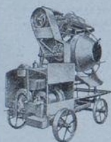
RYCHLOMIXAČ světové značky orig. „JAEGER“ s ležatým sklopným bubnem pro 150-750 litrů.
